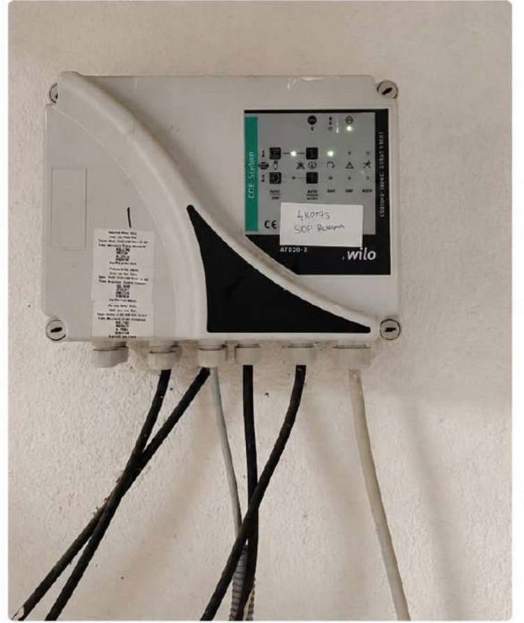
A4 Blok sığınak kuyu taşma pompası arızaya geçmiş, onarım ve kontrolleri yapılarak devreye alınmıştır.
