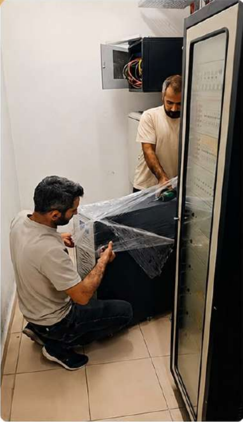
B2 Blok'ta arızalı olan UPS, servis onarımının ardından yeniden monte edilerek devreye alınmıştır.
