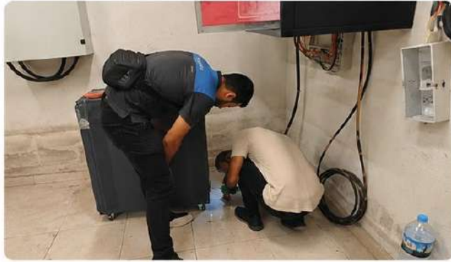
T1 Blok arızalı olan UPS, servis onarımının ardından yeniden monte edilerek devreye alınmıştır.
