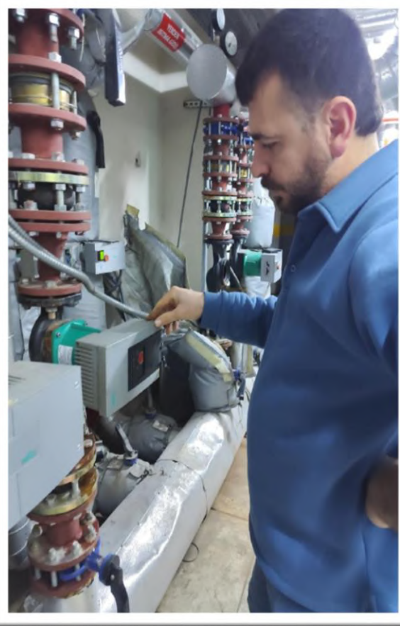
Havuz sirkilasyon pompası bakımları yapılmıştır
