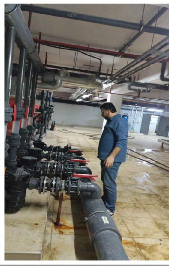
Havuz sirkilasyon pompası bakımları yapılmıştır
